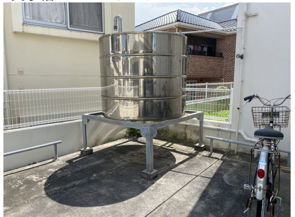
5.受水槽フェンスまわり
