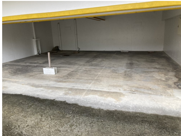
1. 駐車場・駐輪場
