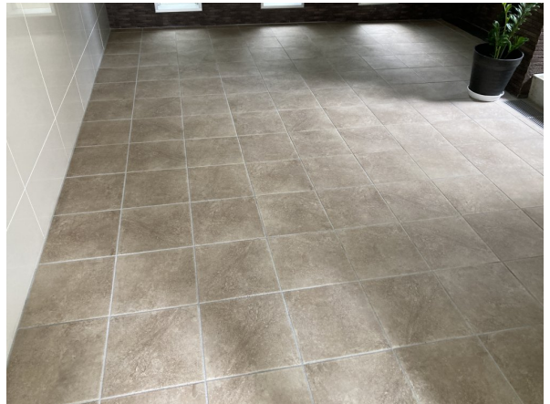
5.EV・ホール
