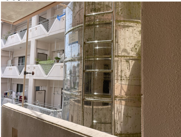
4.受水槽フェンスまわり
