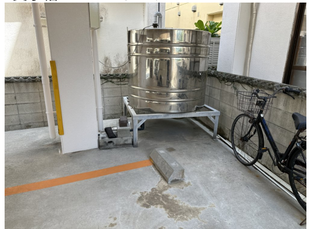
4.受水槽フェンスまわり
