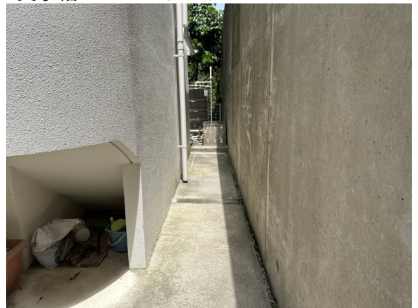
2. 受水槽フェンスまわり
