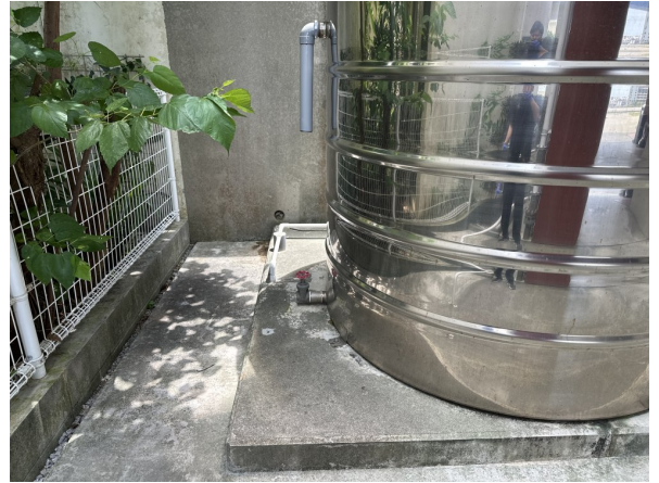
2. 受水槽フェンスまわり
