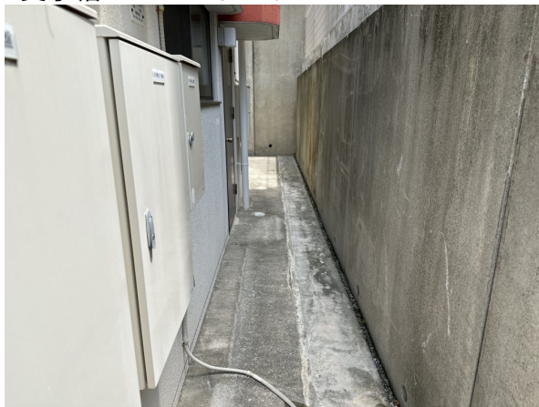
2. 受水槽フェンスまわり
