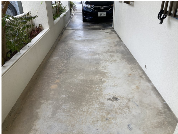
1. 駐車場・駐輪場
