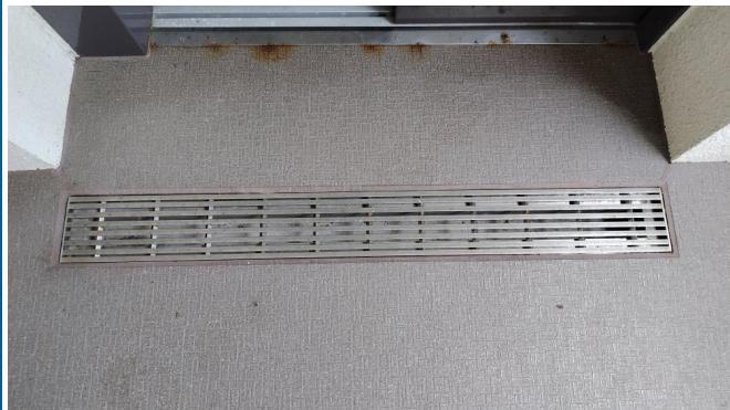
2.EV・ホール
