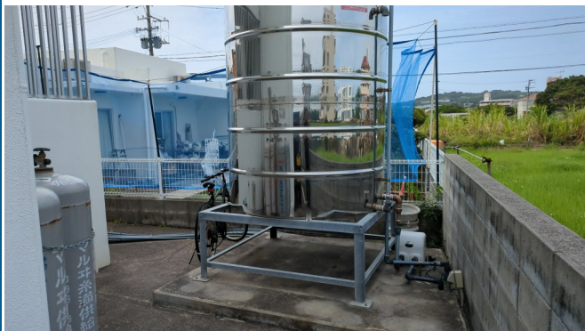
2. 受水槽フェンスまわり
