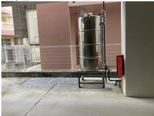
4. 受水槽フェンスまわり
